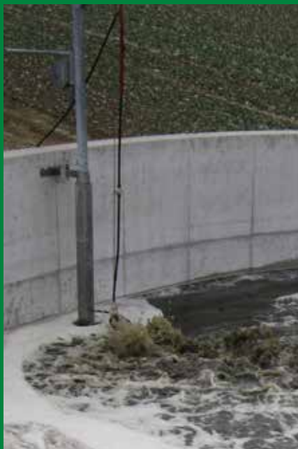
Miešadlo so zdvíhacím a natáčacím zariadením
