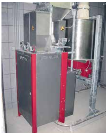
Tender-CCM prednádrž z nerezovej ocele s objemom do 8 m 3
