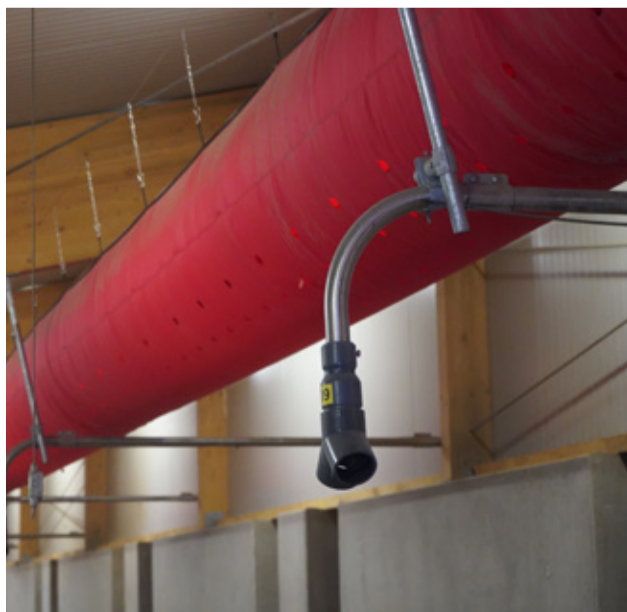
Tunelové vetranie zabezpečuje čerstvý prívod vzduchu.
